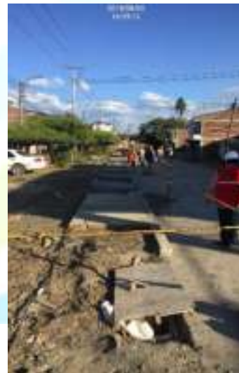
Fundición de sardineles
