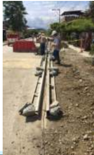
Fundición de sardineles
