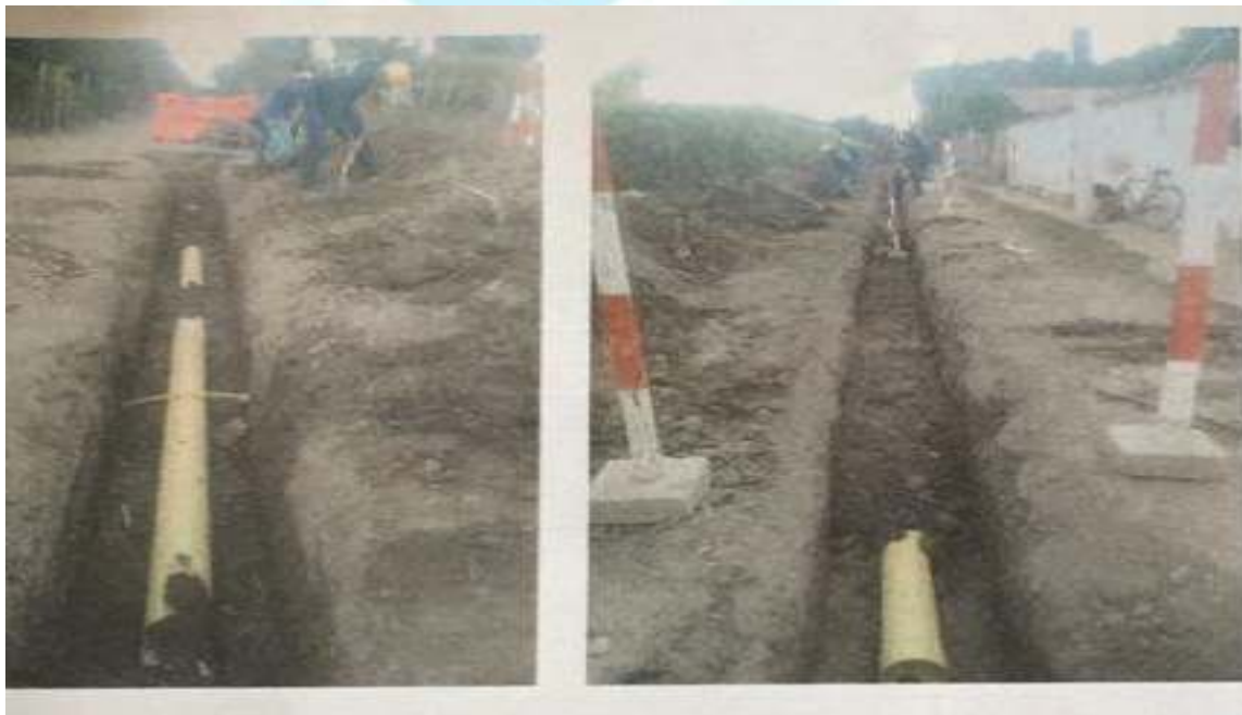
INSTALACION REDES DE ALCANTARILLADO CORREGIMIENTO DE LA TORRE – SECTOR VERGARA
