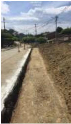
Relleno con material importado
