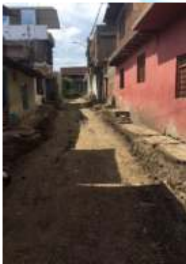
Relleno con material importado
